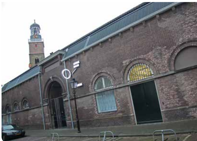
Aan de hand van NTA 8220 wordt in iedere specifieke gebruiksruimte van een gebouw een risico-inventarisatie gemaakt.
